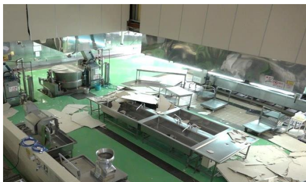
鳥取県中部地震での被害（給食センター）
