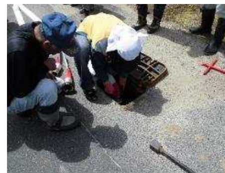
消火栓にホースを取り付ける実践
