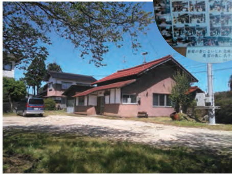
住民だけの力で建てた大沢公民館
