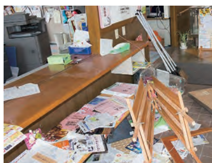
いたるところ破損した社公民館
