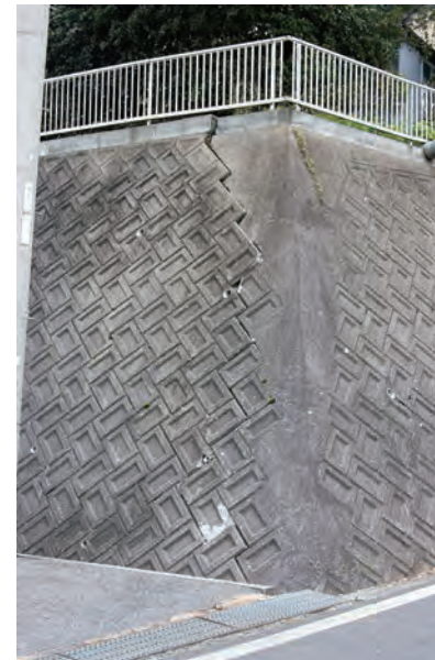
角の法面に亀裂が入った(福光)
