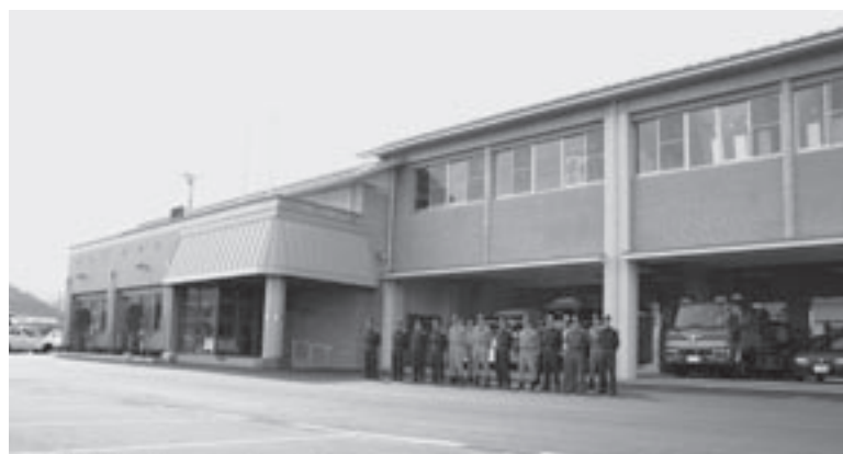
新築された西倉吉消防署
