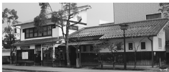
▲「トイレからのまちづくり」による「さわやかトイレ」
