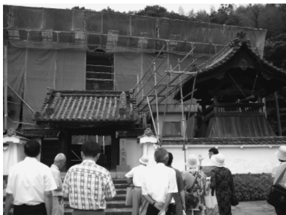
▶水平社結成の中心メンバー西光万吉の生家である西光寺前(補修工事中)
