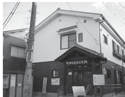
【越中町自治公民館】公民館新築
