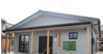
公民館新築(堺町3丁目自治公民館)
