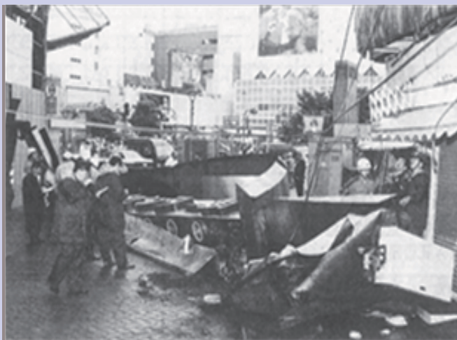
台風で落下した時の様子
