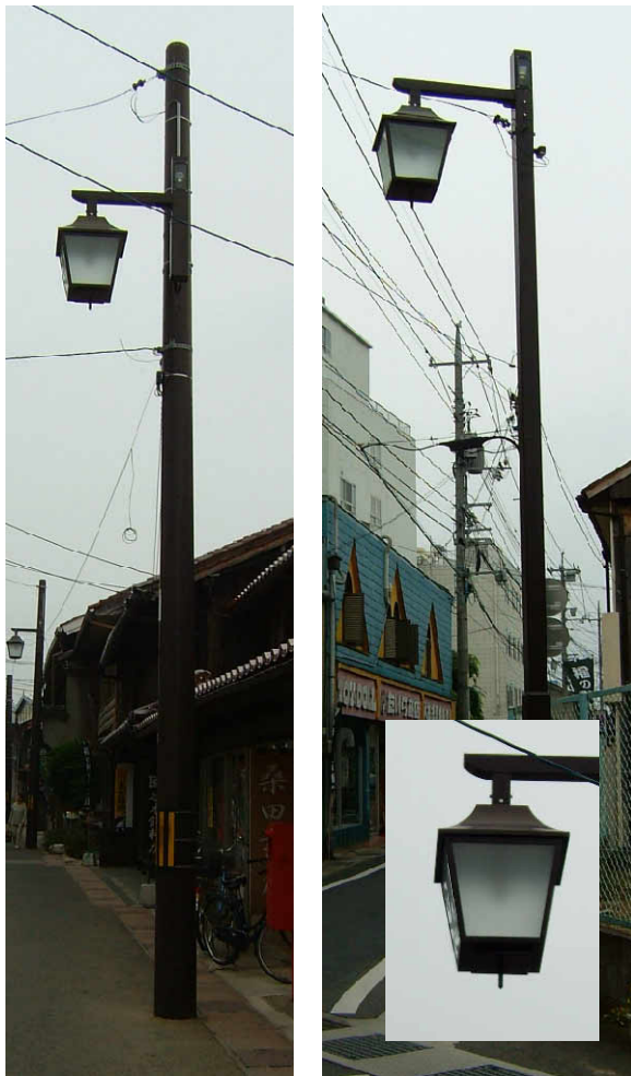
景観に配慮した照明施設の設置
