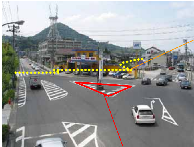
設置予定箇所の現況写真
