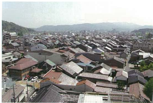
切妻屋根の連なる屋根並
