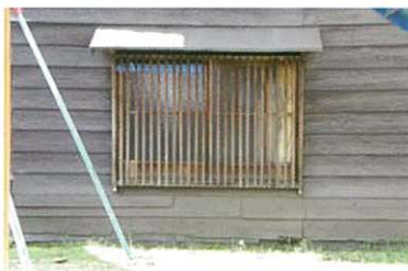
板金系で仕上げられた庇
