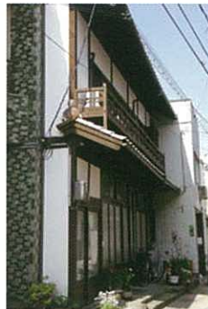
総2階の1階軒庇（日本瓦葺き）
