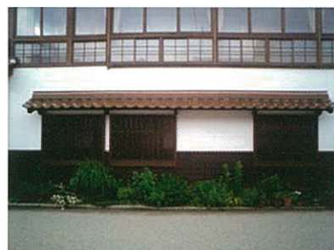
日本瓦で葺かれた庇
