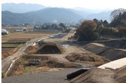
整備中の北条湯原道路
