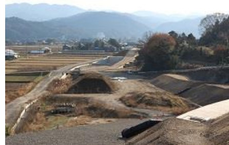
整備中の北条湯原道路
