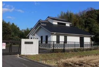
東鴨地区農業集落排水施設
