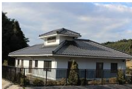
志村地区農業集落排水施設
