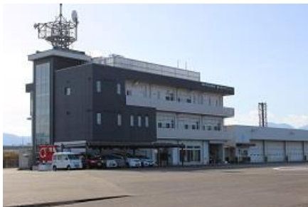
天神川防災ステーション (倉吉市防災センター)
