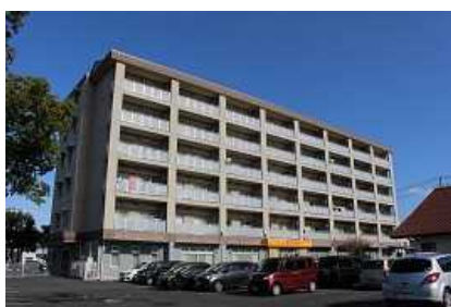
市営住宅（上灘町）
