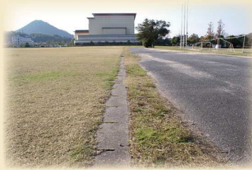
アスファルト舗装(撤去)
