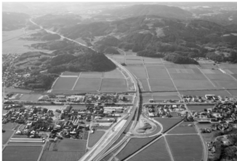
<地域高規格道路北条湯原道路（北条倉吉道路）>
