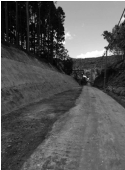
<市道大谷中央線線道路改良工事 (平成28年度完成予定)>
