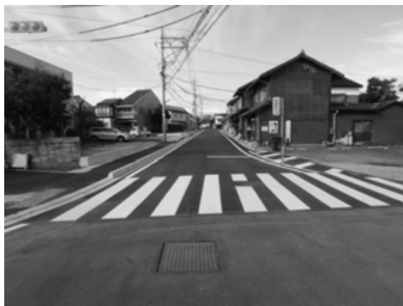
<市道瀬崎町鍛冶町2丁目線道路改良工事（平成27年度完成）>
