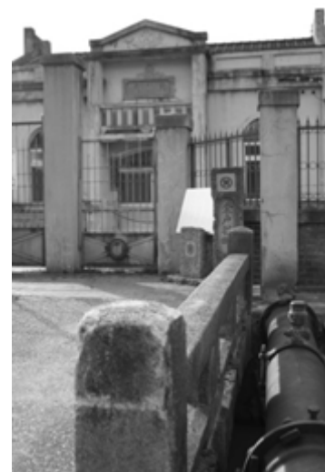
<余戸谷町水源地>
