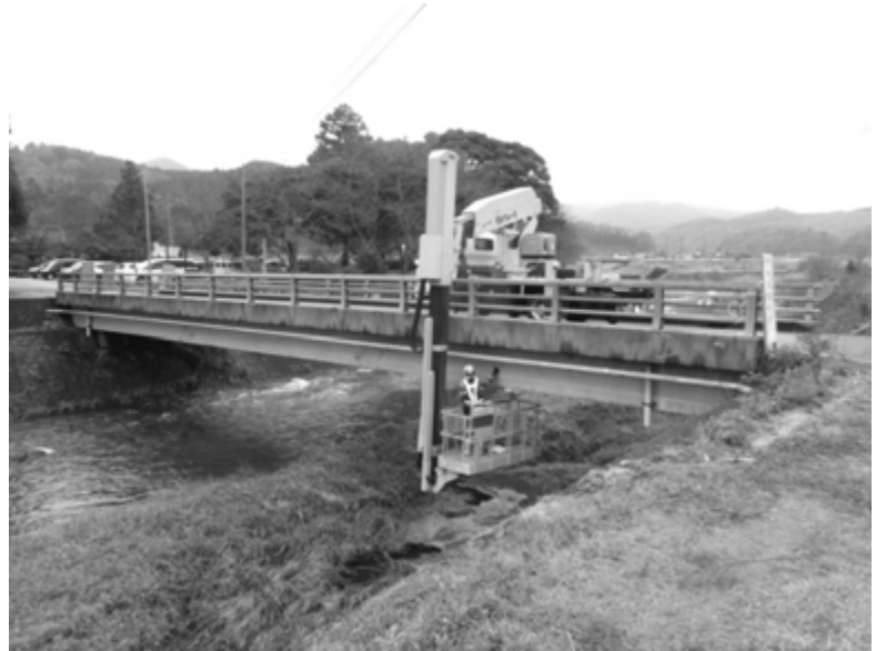
<大宮橋橋梁定期点検>
