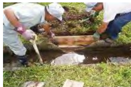
U字溝の改修作業
