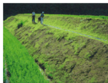
小段が設置されている法面
