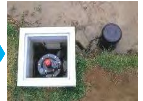
給水栓の自動化へ改良
