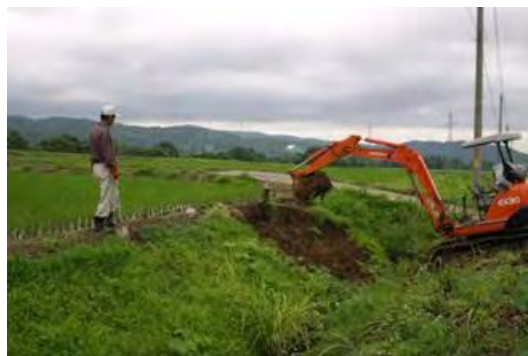
農用地法面の補修
