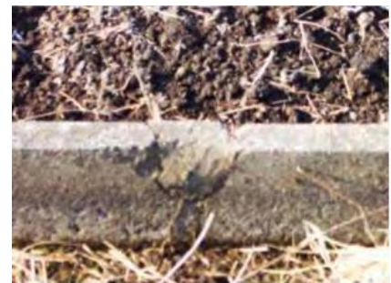
欠損箇所の補修（側溝） （モルタルによる補修）
