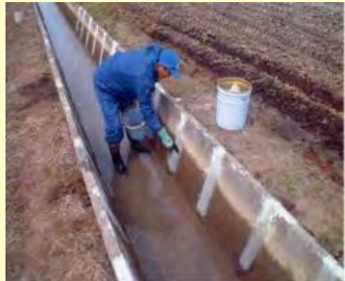
目地詰め作業
