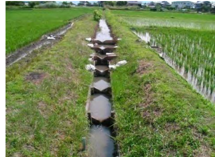
水路魚道（排水路堰上施設）
