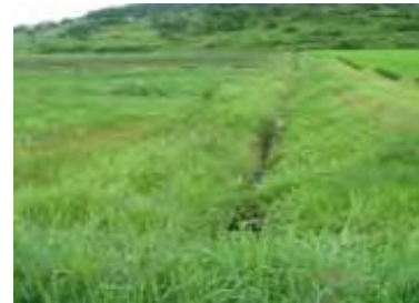
雑草の繁茂状況
