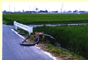
ポンプアップ状況
