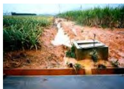
土砂の流出状況
