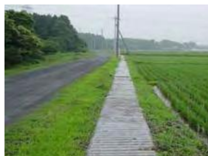
水路へのコンクリート蓋の設置
