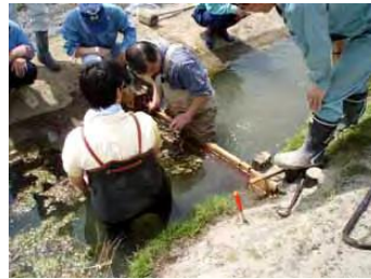
魚道の設置状況（堰板の設置）
