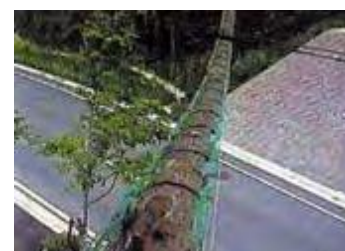
橋梁設置例 （出典：清水建設）
