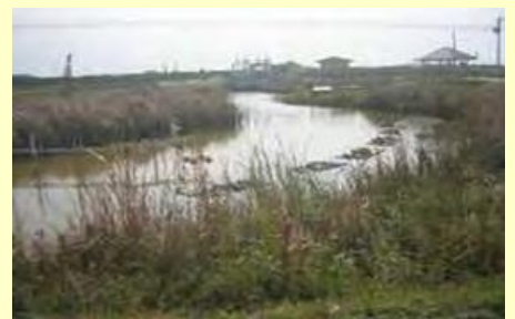
浄化池の状況
