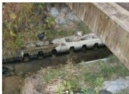
多孔コンクリート護岸
