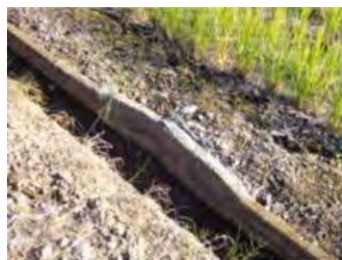
改修したU字溝
