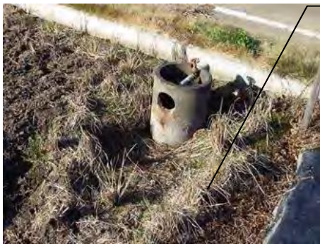
(ファームポンド等) 調整施設に損傷がないか
