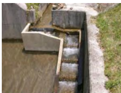
段差解消水路
