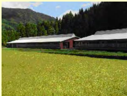
たい肥プラントの外観
