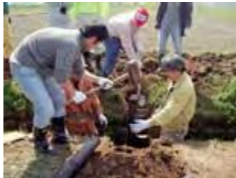
魚道の設置状況
