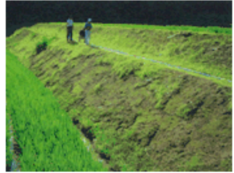
小段（犬走り）設置後の法面
