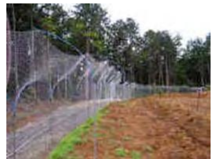
防護柵設置状況
