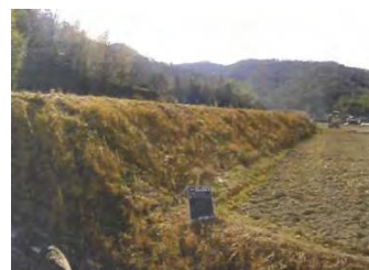
高低差のある畦畔法面
