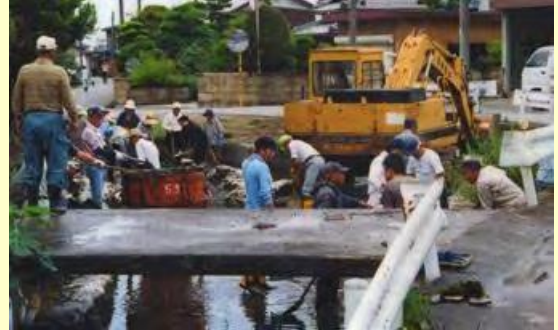
集落での泥上げ作業
