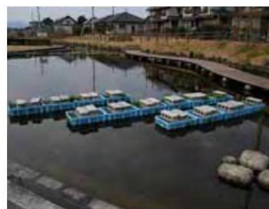
木炭浄化（接触酸化法の一つ）
