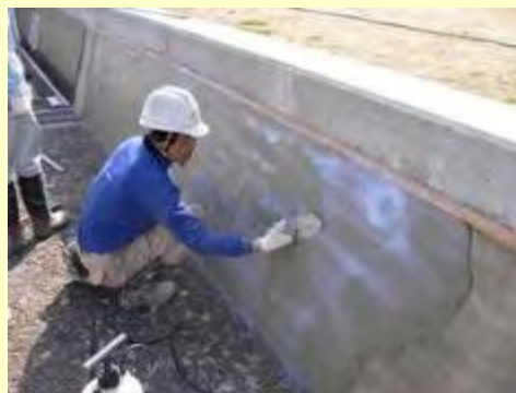
コーティング作業の状況
