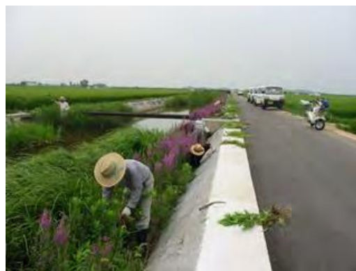
水質浄化水路
