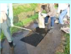
農道の部分補修
