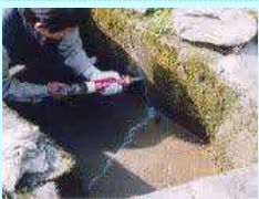
水路のひび割れ補修
