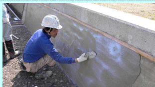
老朽化した水路壁のコーティング
